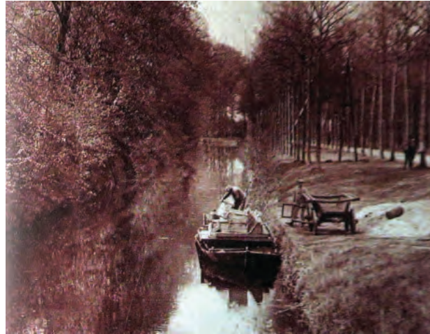
Aanlegplaats voor schepen aan de Prinsenwijk, 1924. Rechts de Bredesingel (Van Limburg Stirumweg). (Bron: Liemburg, 2012, p. 175).
